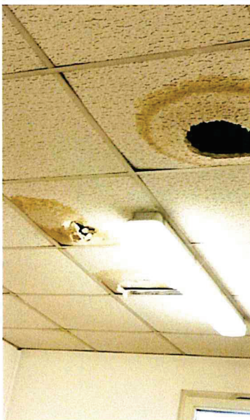
Foto 07 – Foto 08 - Foto 09 - infiltrazioni d'acqua dalla copertura
