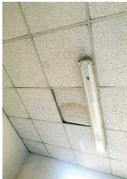
Foto 07 – Foto 08 - Foto 09 - infiltrazioni d'acqua dalla copertura
